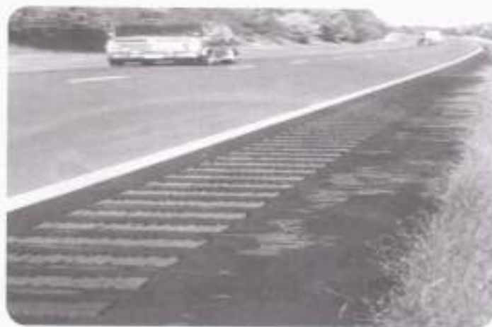
รูปที่ ๒๒ ตัวอย่างการทำแถบชะลอความเร็วบนไหล่ทาง
