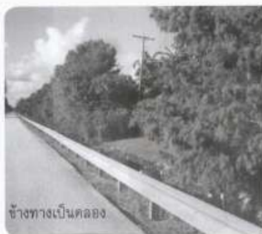
รูปที่ ๑ การติดตั้งราวกันอันตรายบริเวณที่ข้างทาง
