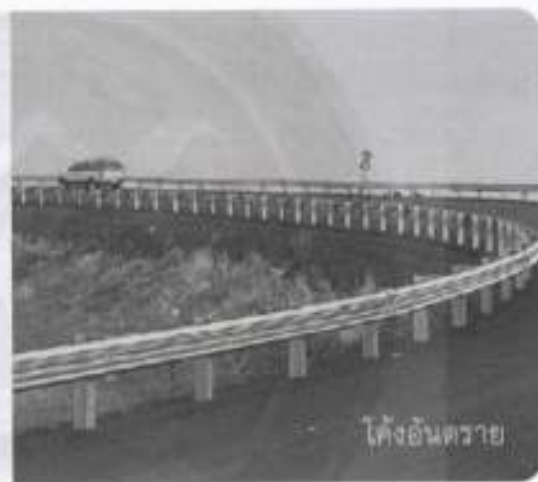
รูปที่ ๑ การติดตั้งราวกันอันตรายบริเวณที่ข้างทาง
