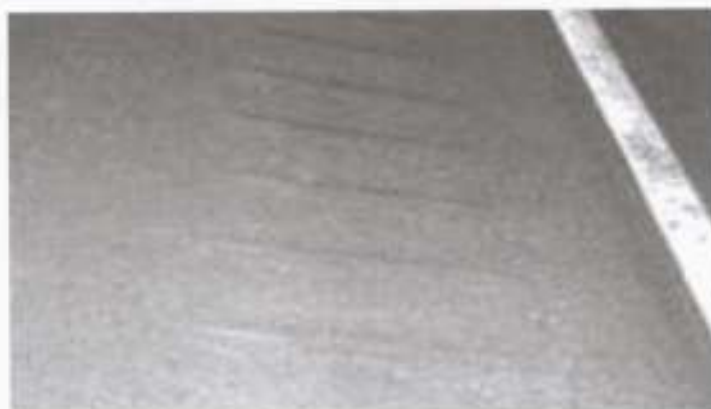
รูปที่ ๒๔ แถบชะลอความเร็วข้างทางแบบ (Rolled)
