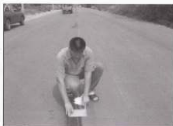
รูปที่ ๓๓ การวางแผ่นเหล็กตามแนวที่จะทาสิ
