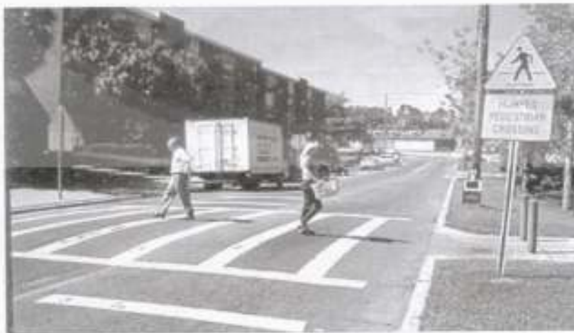
รูปที่ ๓๗ เนินชะลอความเร็วที่ให้ผู้คนเดินเท้าสามารถใช้เดินข้ามถนนได้ Raised Crosswalk
