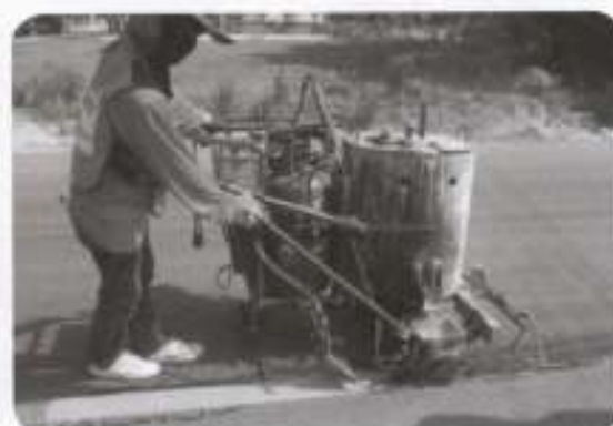
รูปที่ ๓๒ การทำ Primer ด้วยผลิตภัณฑ์ของผู้ผลิตสี ทำการทาสีด้วยเครื่อง ที่ควบคุมอุณหภูมิได้ รูปขณะดำเนินการตีเส้นจราจร
