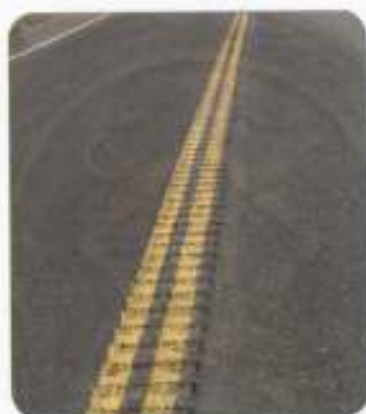
รูปที่ ๒๑ ตัวอย่างการทำแถบชะลอความเร็วบนกึ่งกลางทาง
