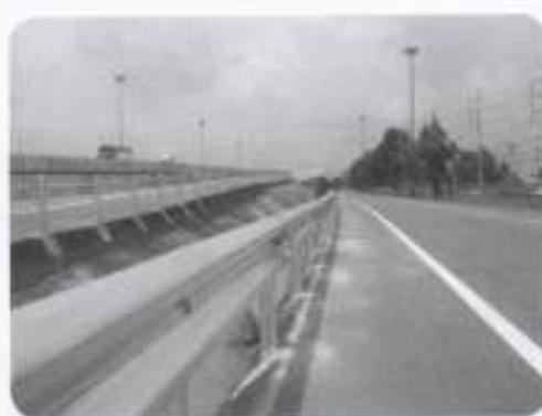
รูปที่ ๒ การติดตั้งราวกันเกาะกลางถนน
